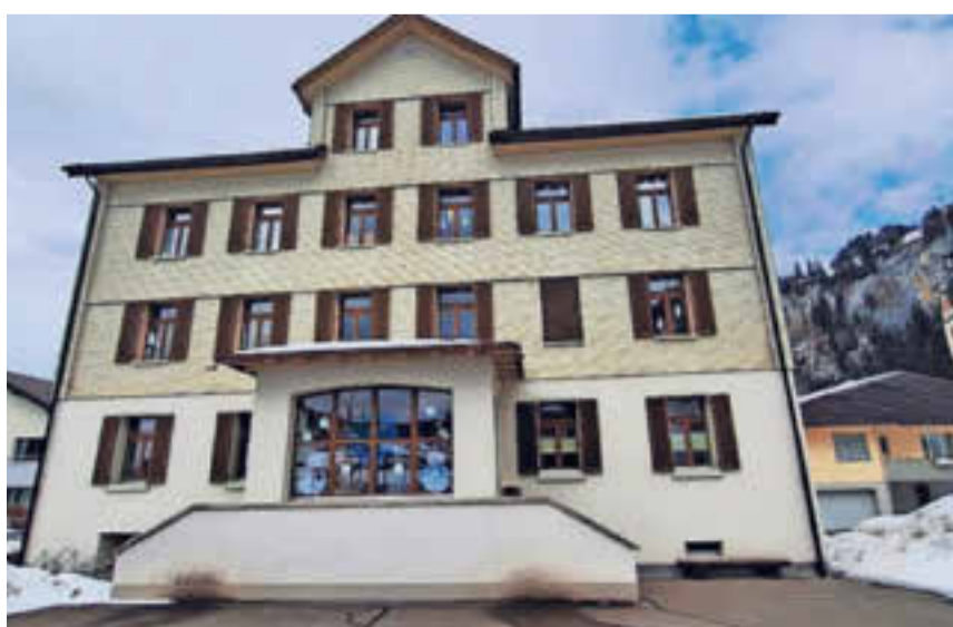
Das 150 Jahre alte Schulhaus an der Waagtalstrasse 29 in Unteriberg. Es erfüllt die sicherheitsrelevanten Standards nicht mehr.
